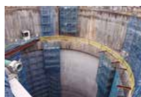
施工中の分流立坑
